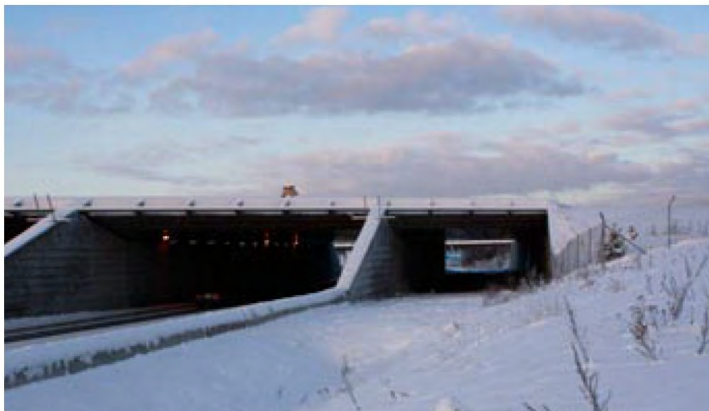
Figur 30 Vägporten under taxibana U används inte för nuvarande och kan med viss ombyggnad användas av Roslagsbanan.
